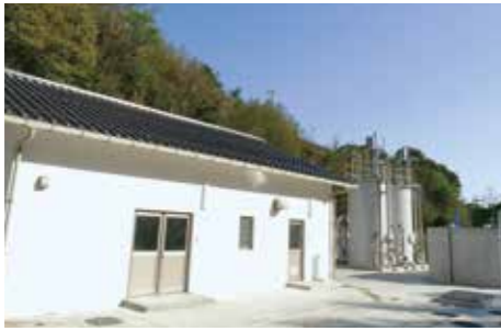
ひのみさきじょうすいじょう 日御碕浄水場
