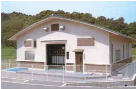
たきじょうすいじょう まくしよりしせつ 多伎浄水場 (膜処理施設)
