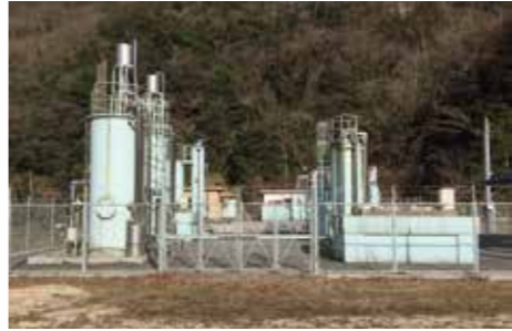
よどはらじょうすいじょう 淀原浄水場
