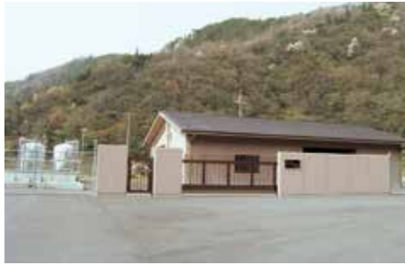
ひでじょうすいじょう 日の出浄水場
