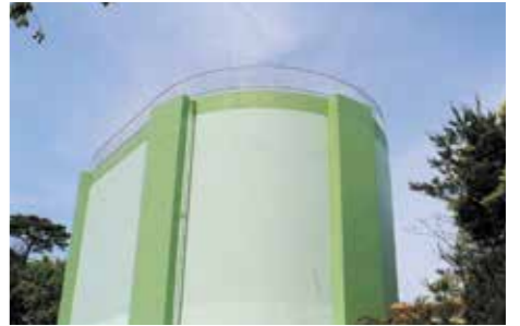
しんあたいまはいすいち 新愛宕山配水池
