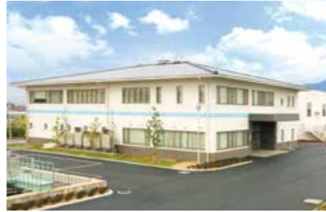
こりはらじょうすいじょう 来原浄水場
