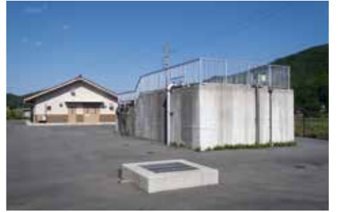
かみつじょうすいじょう 上津浄水場
