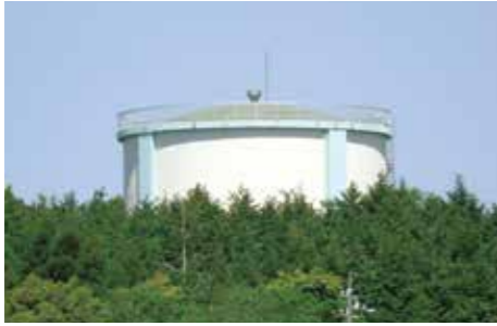
こりょうはいすいち 湖陵配水池
