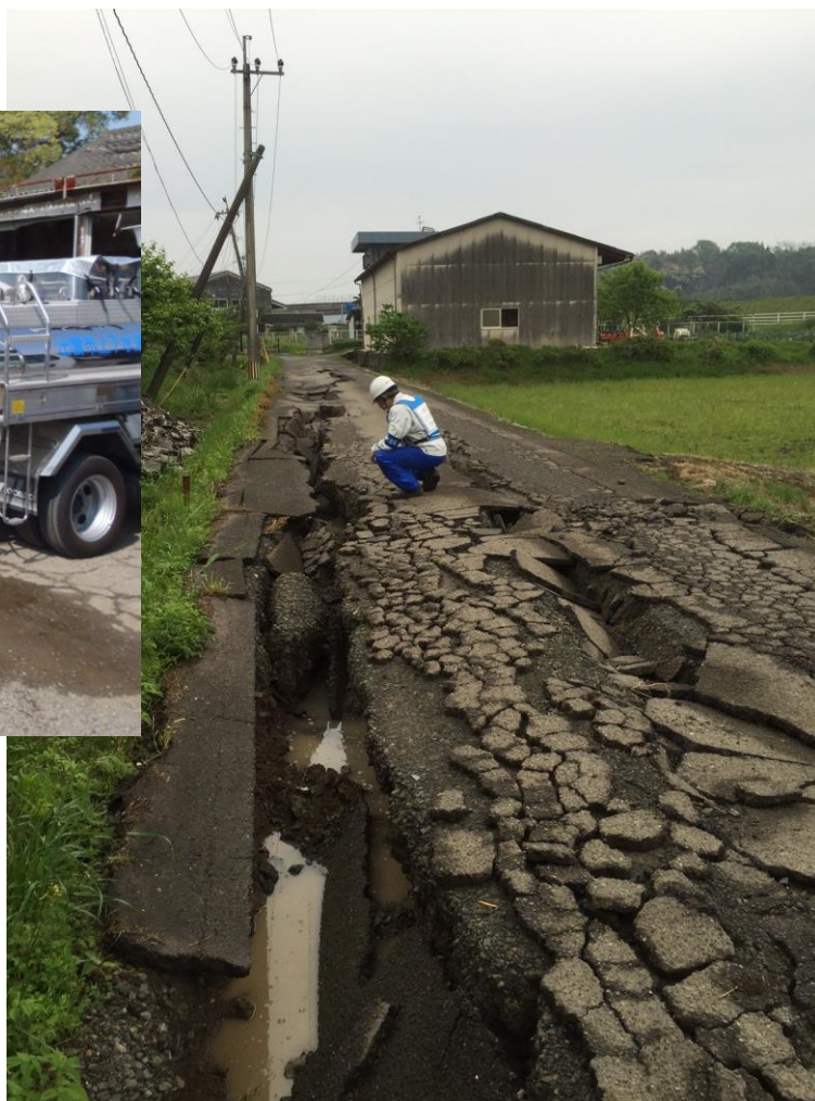
熊本県御船町の道路の被災状況
