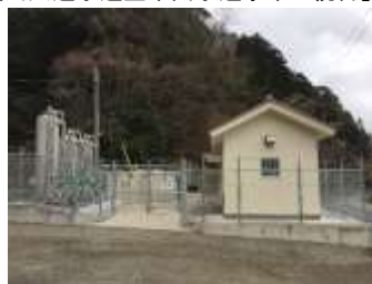
美保塩津浄水場
