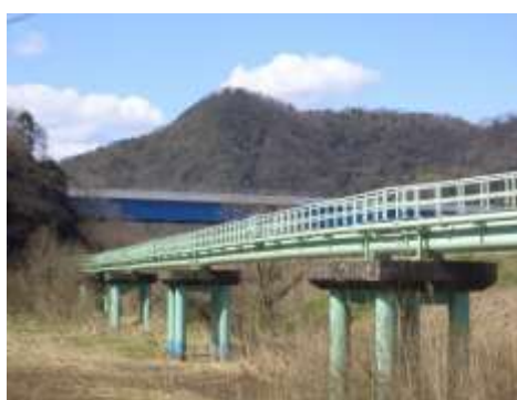
岩棚池水管橋（導水管）
