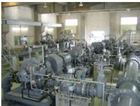
来原浄水場送水ポンプ室
