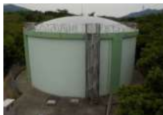
愛宕山配水池
