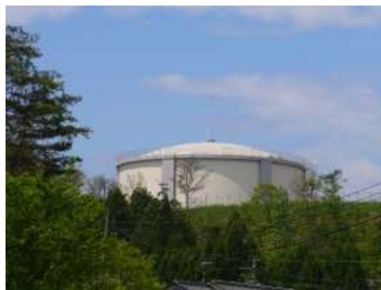
新向山配水池（容量 7,000 m 3 ）
