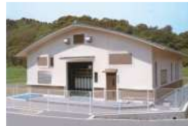
多伎膜処理施設棟
