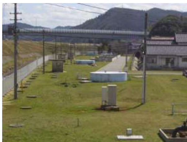
来原水源地下水井
