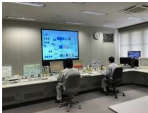
来原浄水場中央監視室
