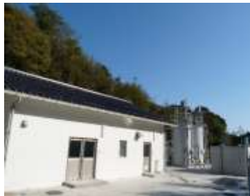
日御碕浄水場
