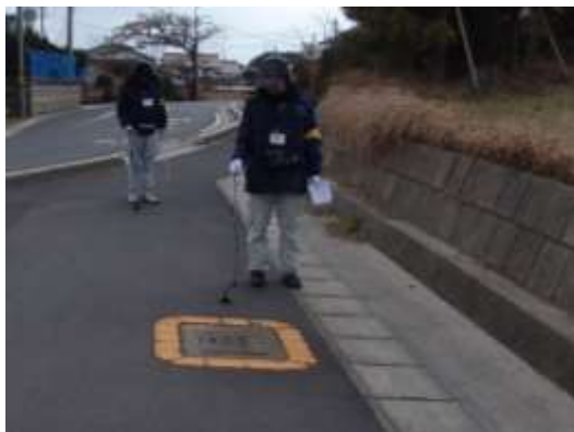
漏水調査(管路、給水装置)
