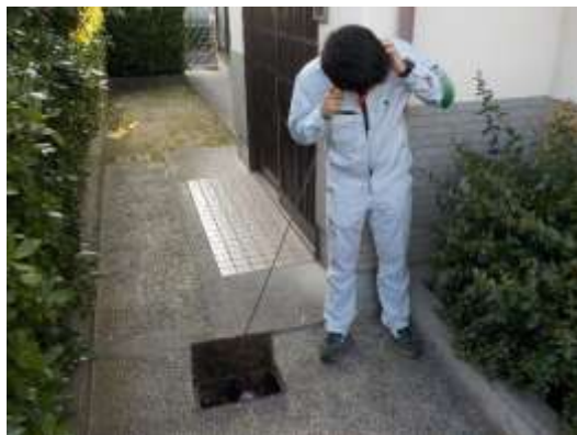
漏水調査(管路、給水装置)
