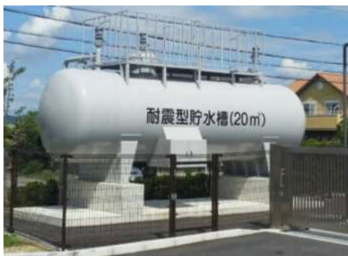
耐震性緊急貯水槽
