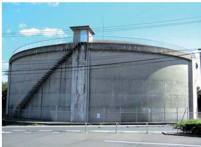
▲建設後40年以上経過した向山配水池(容量10,000 \text{m}^3 )
