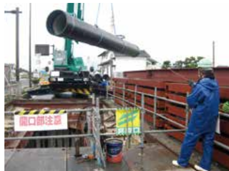
▲本管布設工事の様子
