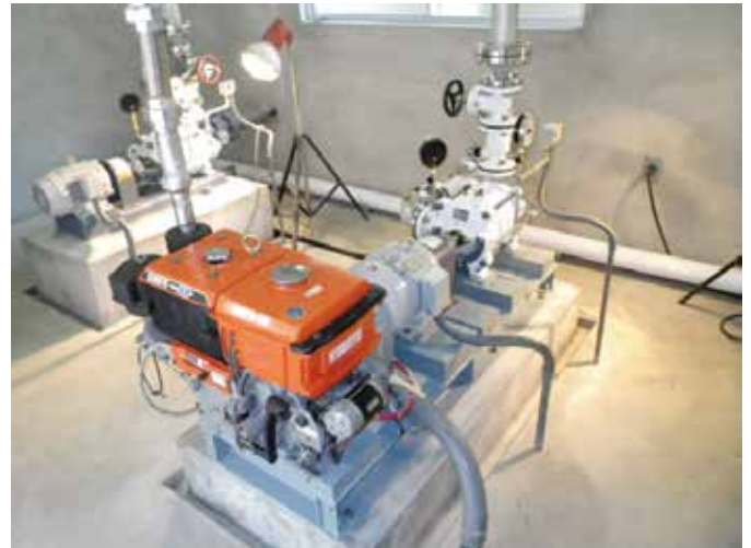
▲更新した基幹施設のポンプ設備 (窪田簡易水道の吉野ポンプ場)
