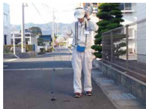
▲漏水調査の様子
