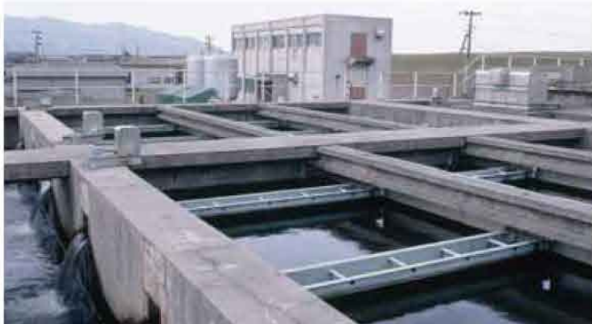
▲来原浄水場、沈澱池
