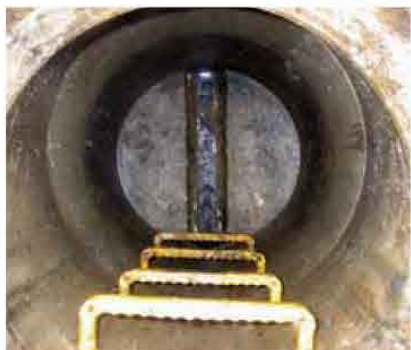
▲正常なマンホールは、真ん中の溝を汚水が流れていきます。
