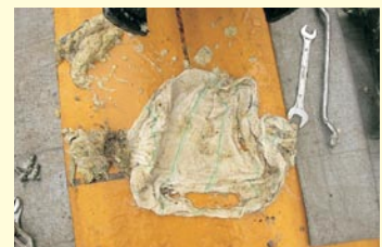
▲マンホールからポンプを引き上げ、詰まっていたタオルを取り出しました。
