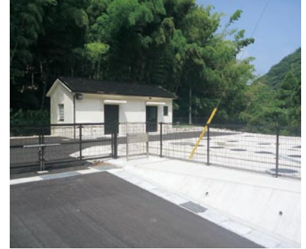
▲平成24年3月に「鷺浦地区漁業集落排水処理センター」が完成しました。
