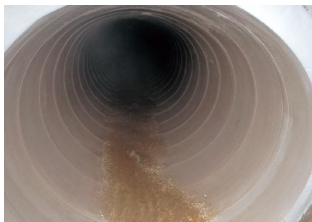
▲管路更生工事により新品同様になった下水道管
