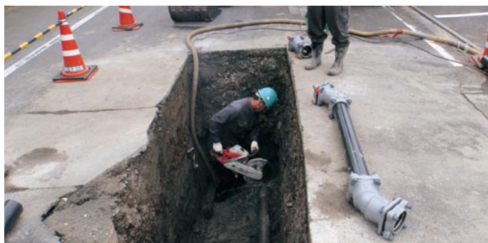
◀水道配水管の漏水修理工事
