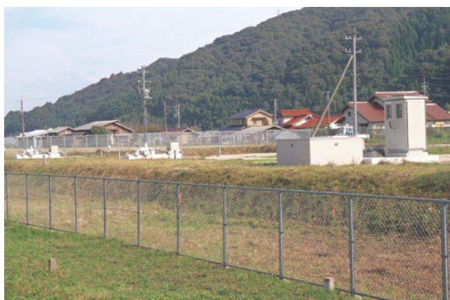
▲上島水源地での取水井築造
