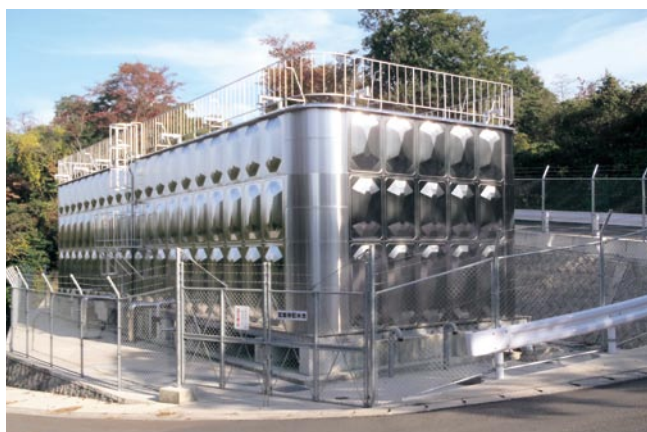
▲湖陵地域へ給水するための新常楽寺配水池(容量690㎡)
