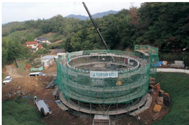
▲河下地区への給水拠点となる布勢配水池(建設中)
