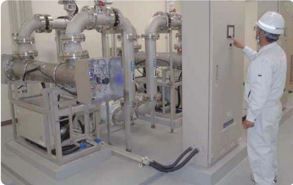
▲上津浄水場の新施設に設置した紫外線処理設備
