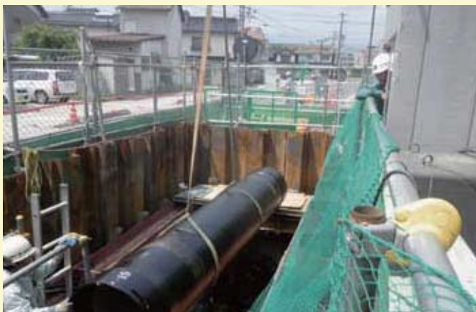
◀大津町地内での幹線配水管(φ700mm)の布設工事(推進工法)
