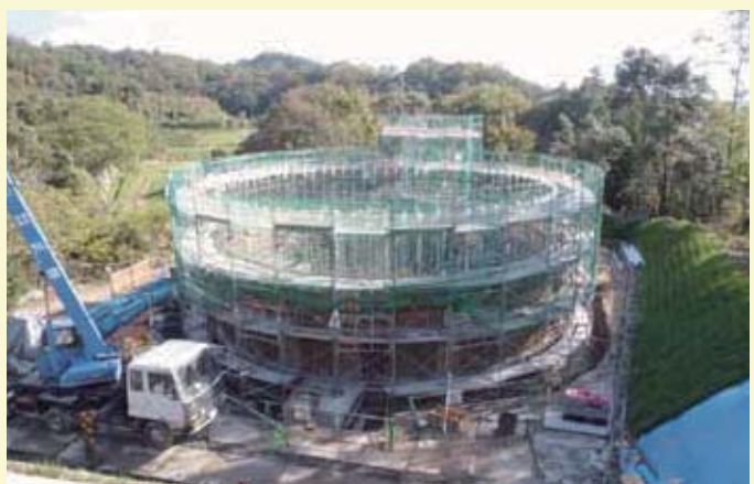
苅藻谷配水池の築造工事▶
