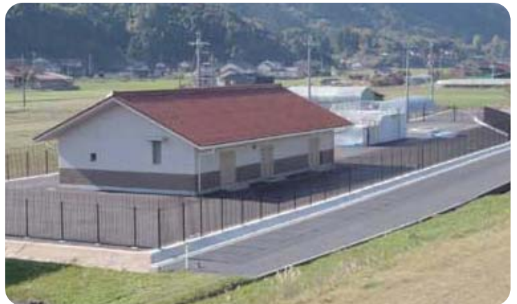
▲上津浄水場新施設の外観
