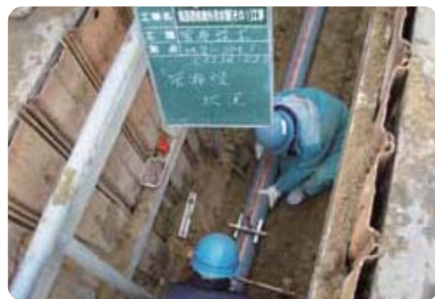
▲下水道管の布設状況
