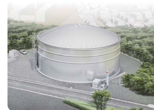
▲建設中の向山配水池 (完成イメージ)
