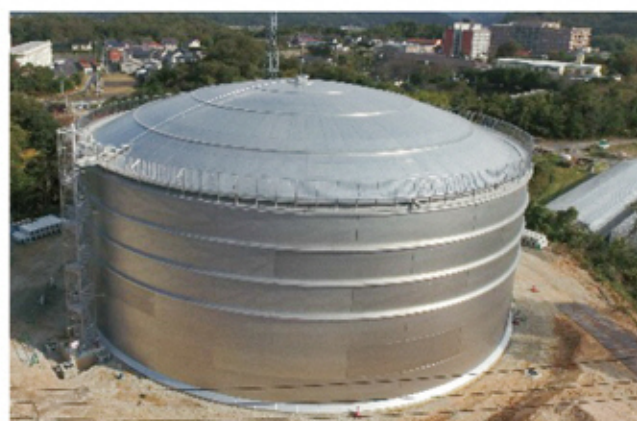
完成間近の新たな向山配水池
