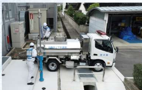
応急給水塔から給水車への水補給の様子
