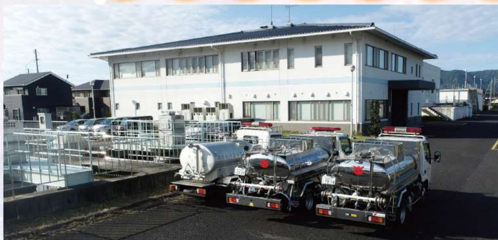
来原浄水場管理棟と給水車
