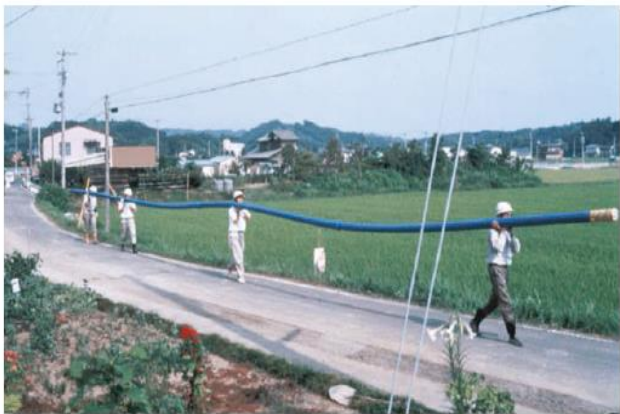
図 2-6 水道配水用ポリエチレン管（電気融着継手）
