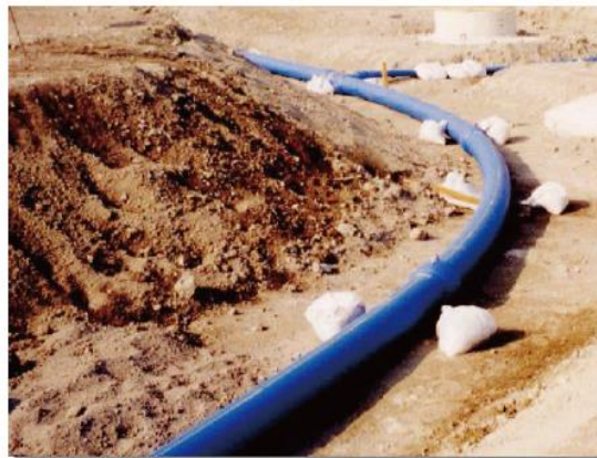
図 2-6 水道配水用ポリエチレン管（電気融着継手）
