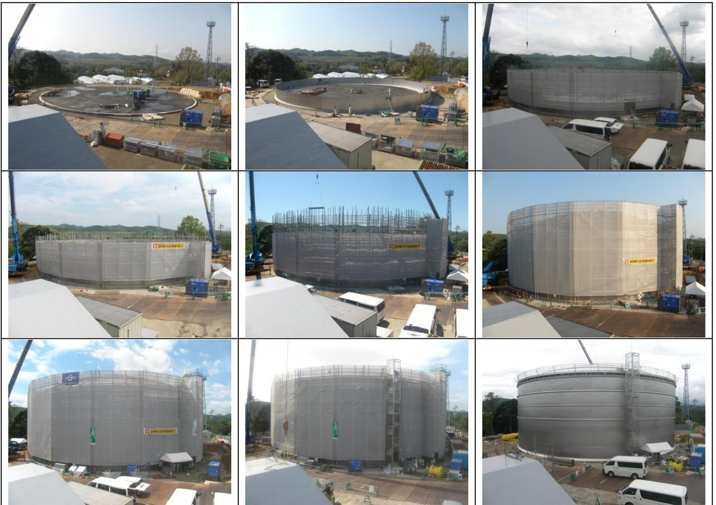
⑥平成30年 5月～10月 ステンレス製の材料を(6段)組上げて、配水池を作っていきます。有効容量は、9,000 $\text{m}^3$ になります。25m プール (25m $\times$ 10m $\times$ 1.5m=375 $\text{m}^3$ ) 24杯分です。
