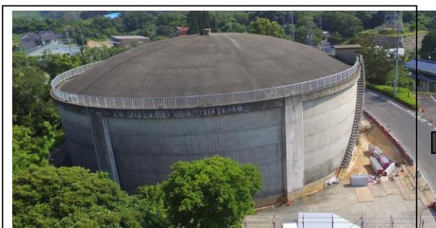
取壊し前の向山配水池 (コンクリート製・昭和48年建設、有効容量10,000 m<sup>3</sup>)
