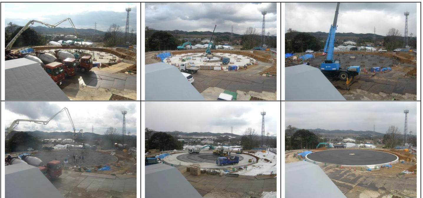
④平成30年2月 ステンレス製の配水池を建設する土台（基礎）ができました。これから配管やステンレス製のタンク（直径34m、高さ16m）を作っていきます。
