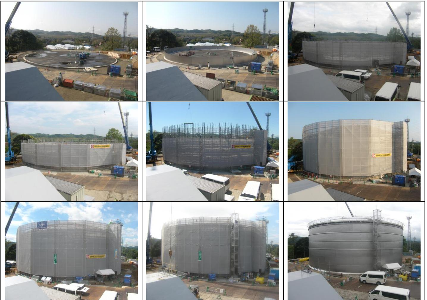
⑥平成30年5月～10月 ステンレス製の材料を(6段)組上げて、配水池を作っていきます。有効容量は、9,000 m<sup>3</sup>になります。25m プール (25m×10m×1.5m=375 m) 24杯分です。
