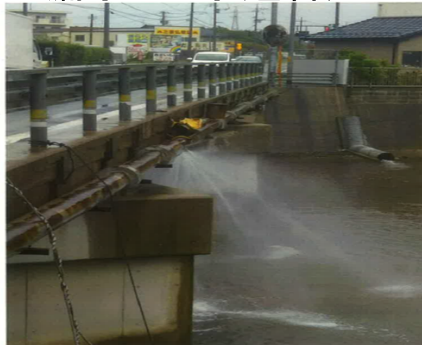
漏水発生場所：出雲市湖陵町（平成30年）
