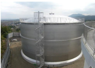
耐震性の高い新向山第2配水池
