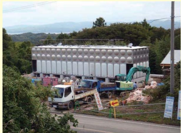
▲水道用水供給施設から受水をするために必要な本郷配水池の築造工事
