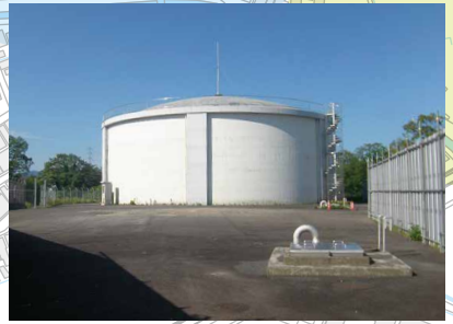
着工前建設用地(新向山配水池 手前)
