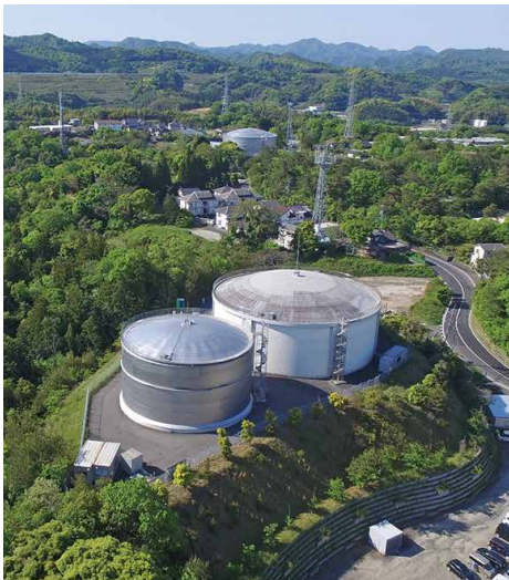
●南向き 奥 / 向山配水池(容量9,000m 3 ) 右手前 / 新向山配水池(容量7,000m 3 ) 左手前 / 新向山第2配水池(容量3,300m 3 )
