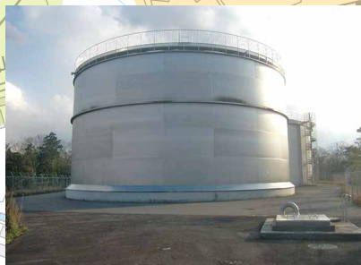
完成 新設ステンレス鋼板製 3,300㎡
