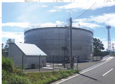
完成 更新ステンレス鋼板製 9,000㎡
