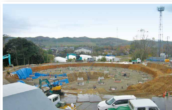
④ 基礎底版施工中
