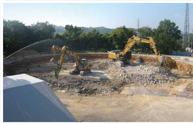
② 旧配水池取壊し施工中
