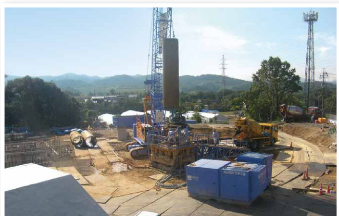
③ 杭基礎施工中
