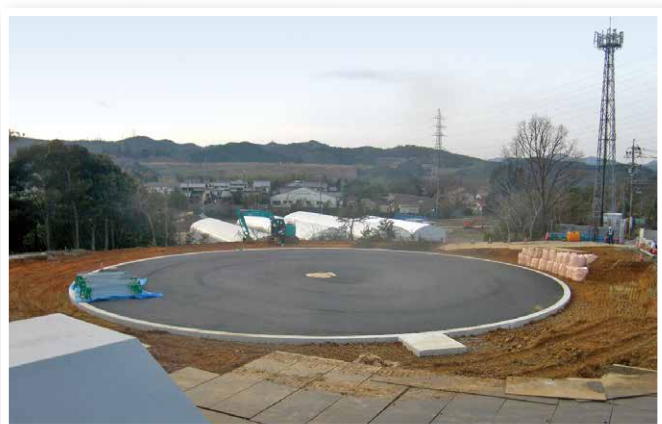
⑤ 基礎底版完了
