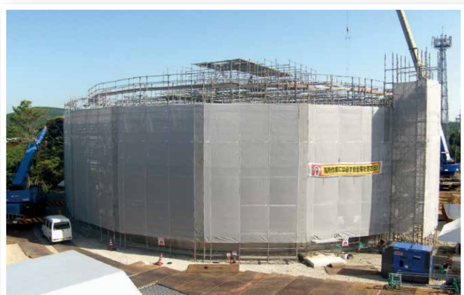
⑦ 配水池屋根構造施工中
