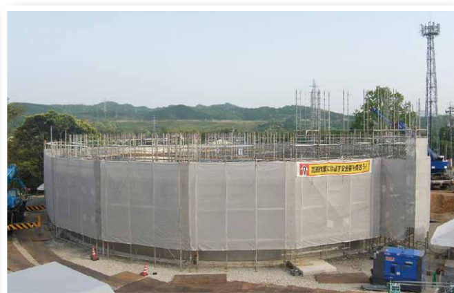
⑥ 配水池側壁施工中
