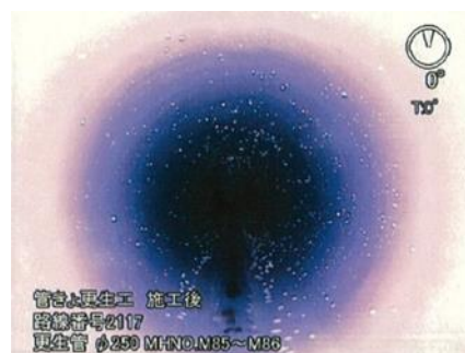
【管更生実施後】
