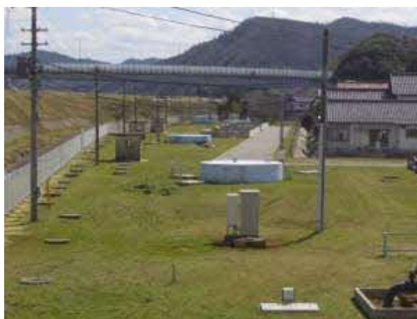
来原水源地下水井
