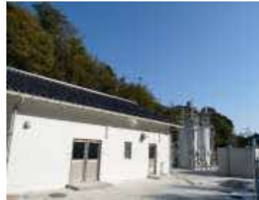
日御碕浄水場
