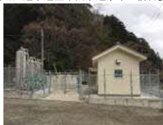
美保塩津浄水場
