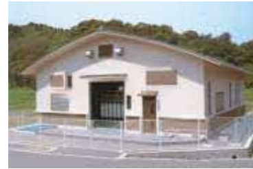
多伎膜処理施設棟
