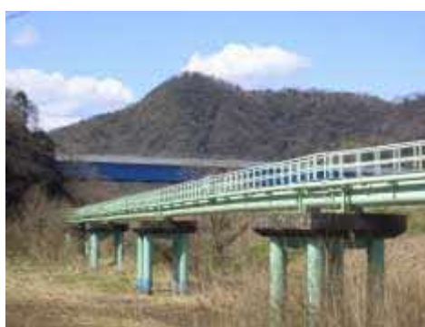
岩棚池水管橋（導水管）
