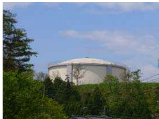
新向山配水池（容量 7,000 m 3 ）
