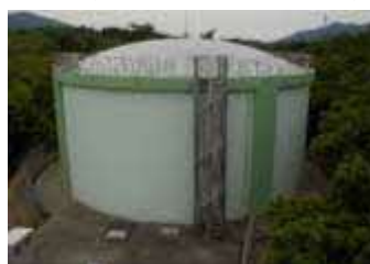
愛宕山配水池
